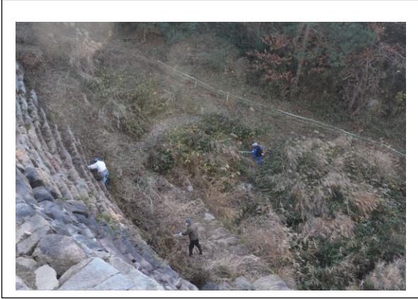
6番砂留及び砂留周辺整備
