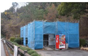
12月より堂々公園トイレ改修
