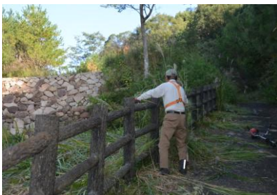
鳶が迫谷整備
