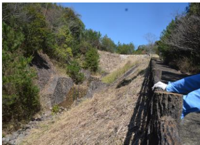
鳶ヶ迫谷を道路から見る
