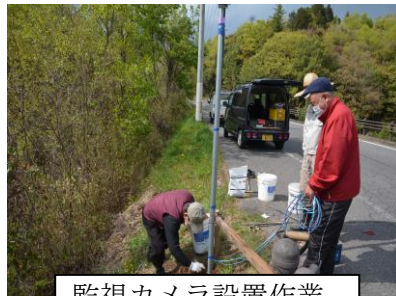
監視カメラ設置作業
