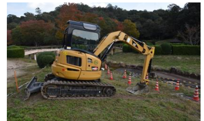
6 番砂留破損修理工事中
