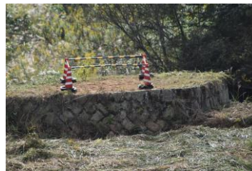
4 番砂留破損修理工事
