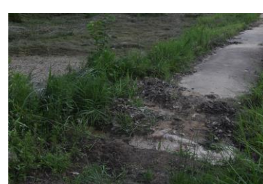
水路不備で起こる土砂を除去
