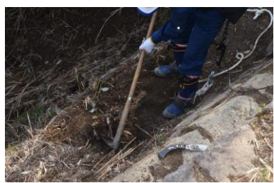
鳶ヶ迫石垣整備 砂1mも堆積
