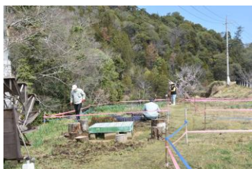
1番砂留周辺整備
