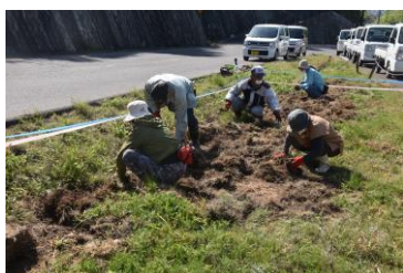
猪被害場補修
