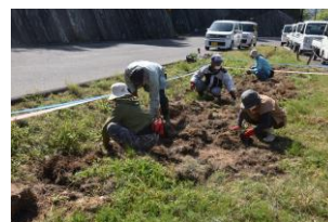
彼岸花場を補修する
