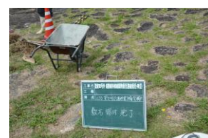
6番砂留修理完了
