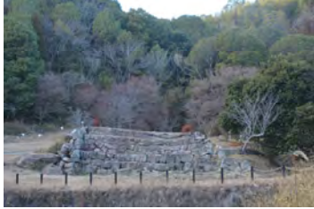
日本最古の 1 番砂留 (奥の石積み手前は迫山砂留)
