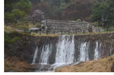
迫山砂留（文化財ではない）
