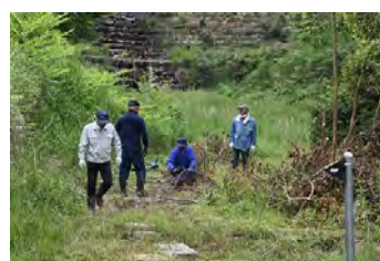
6番砂留下流樹木伐採片付け
